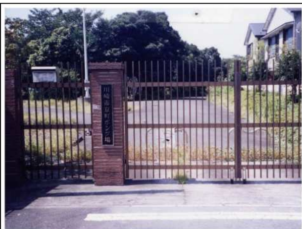
・いつも門がしまっている京町ポンプ場
