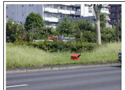
・ 中央分離帯は植栽が放置され、ゴミも多い国道15号線
