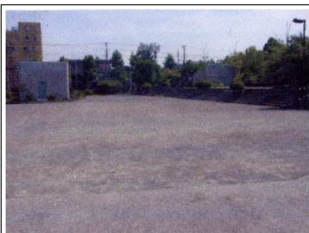
・京町雨水滞水池
