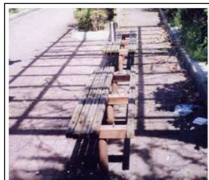
・ 京町緑道の破損したベンチ
