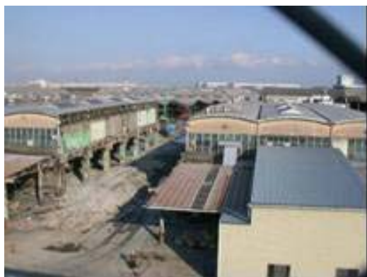
解体される川崎工場
