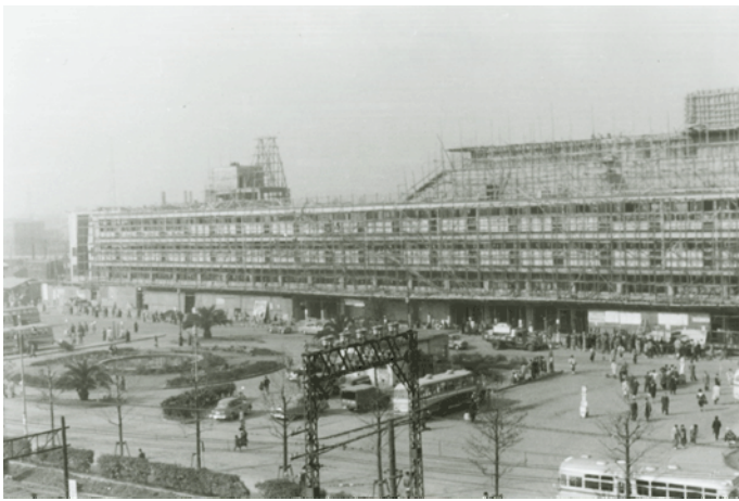
(写真⑩) 建設中の駅ビル
