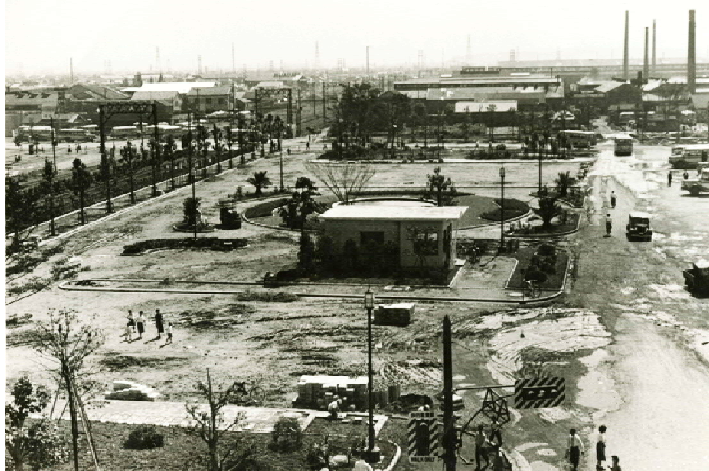
(写真⑨)整備・工事中の川崎駅前 昭和20年前半
