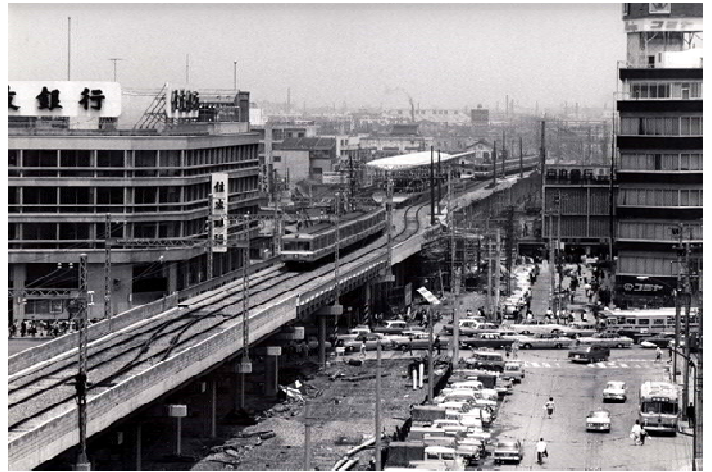
(写真⑩) 高架の完成
