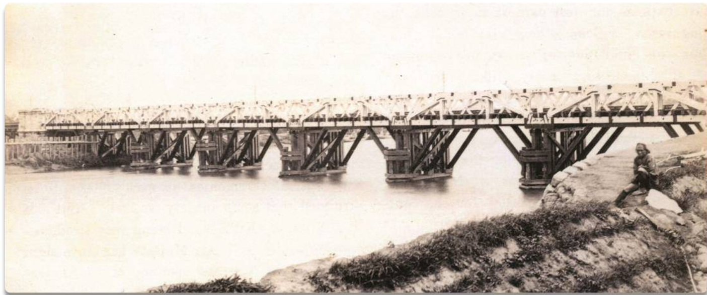
(写真③)多摩川最初の鉄道橋「Far East」1872年(明治5)
