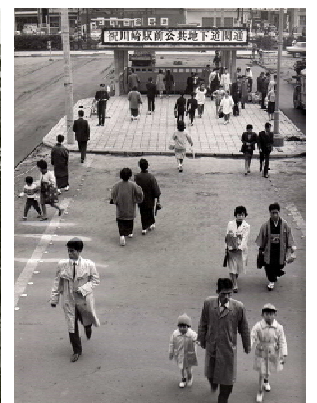
(写真⑭) 地下道の完成
