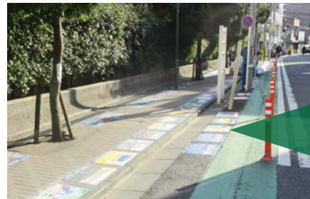
路面シート貼り付け後の歩道
