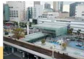
川崎駅東口駅前広場
