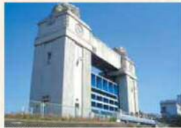
川崎河港水門
