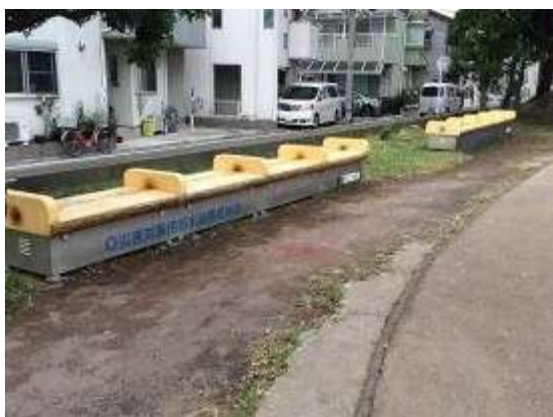
図 11 : 災害対策用給水装置格納庫
