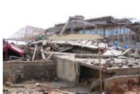
津波による建物破壊
