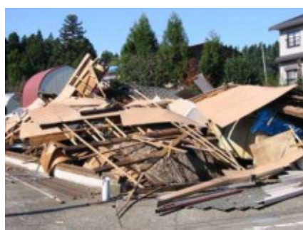
地震による家屋倒壊
