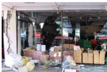
地震による室内被害
