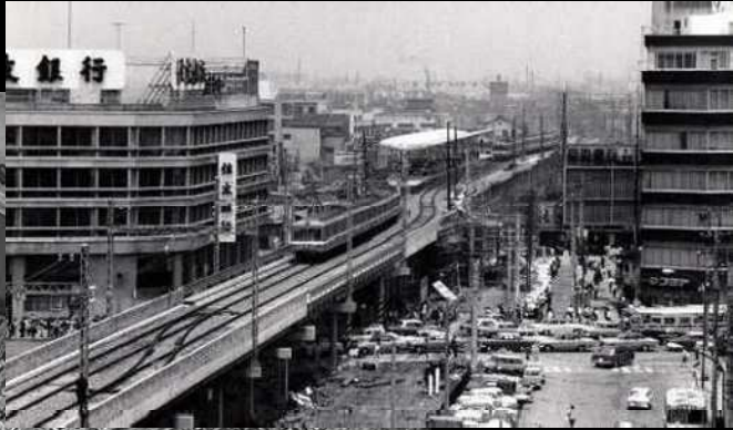
京急高架(昭和41年完成)
