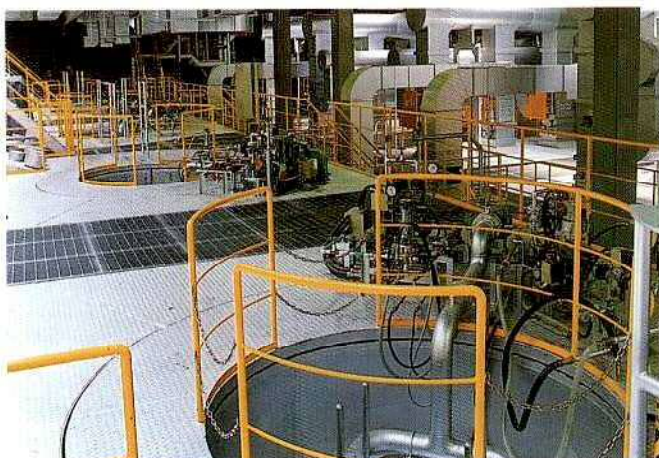
脱塩脱硫反応塔
