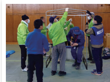
▲ Montagem de banheiros portáteis
