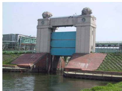
川崎河港水門
