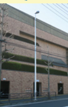
『道路照明灯』の一例▶
