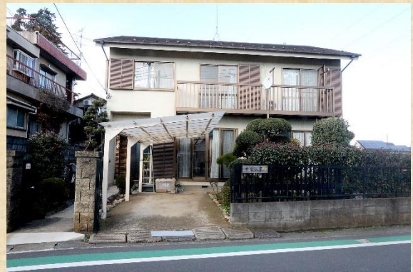
施設外観 （この日は利用者に配慮し、施設内部の撮影は行わなかった）
