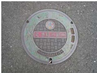
応急給水拠点のマンホール
