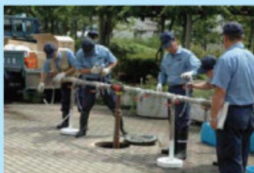
水道局の職員による開設訓練
