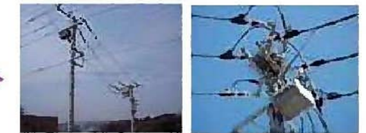
開閉器上部にカラスの営巣(停電原因)。原因を除去し停電解消
