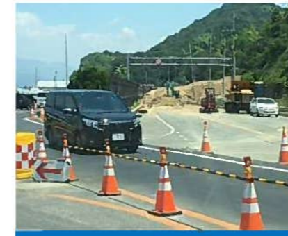
緊急工事での道路開通
