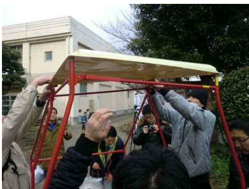
③天蓋の「前」シール方向を入口側に向けて支柱に差し込む。
