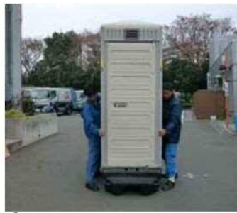
⑰トイレ室部分をタンクに乗せる。
