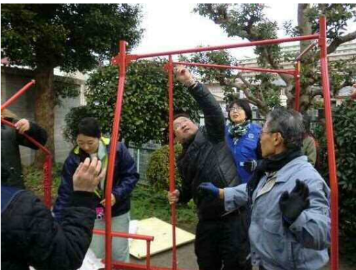
②ロープでつながっている支柱同士を差し込み架台に固定します。黄色テープが貼ってある横支柱を持ち上げる。
