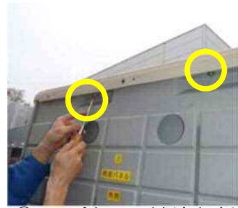
⑮天井パネルは外側もネジ留めをする。
