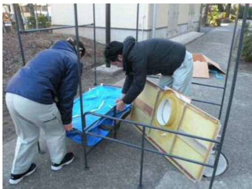
⑤便槽袋を下部フレームに取り付ける。
