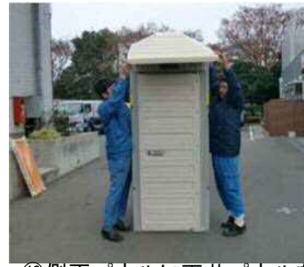
⑫側面パネルに天井パネルを取り付ける。
