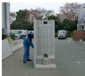
⑤側面パネルを立てる。
