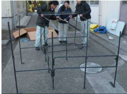
②下部フレームを開き、バックフレームを差し込んで、蝶ネジで締める。
