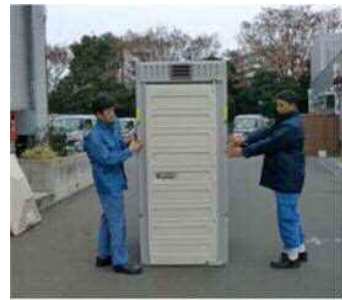
⑨扉パネルを立てる。
