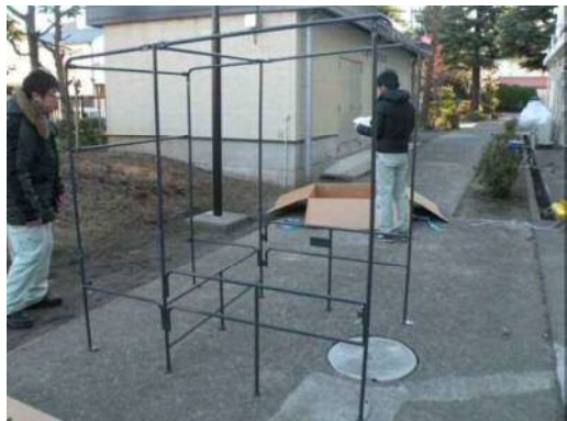
④骨組みの完成
