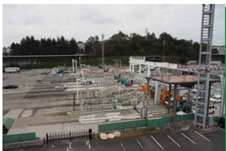
▼改修中の料金所が屋上から見えました！ツアー最後の記念撮影
