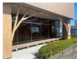
屋外テラス（縁側舞台）
