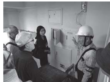
避難所開設ツアー内 特設公衆電話設置
