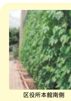
区役所本館南側
