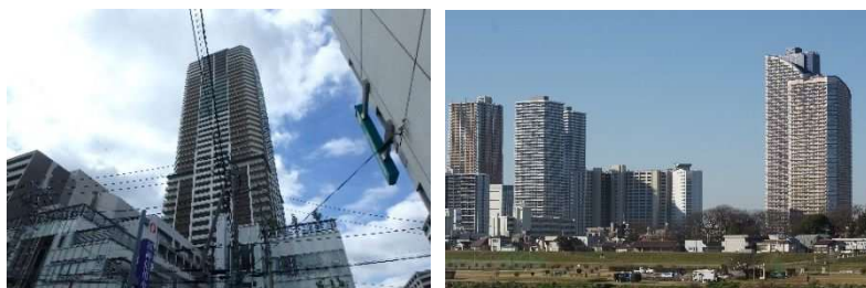
武蔵小杉駅周辺地域の大型高層マンション
