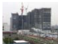
（建設中の大規模マンション）
