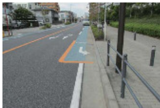
区内の自転車レーン整備事例
