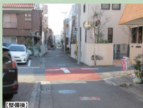
交差点部の注意喚起のため、カラー舗装、十字マークを表示
