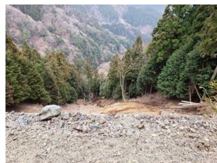
山北町土砂崩れ
