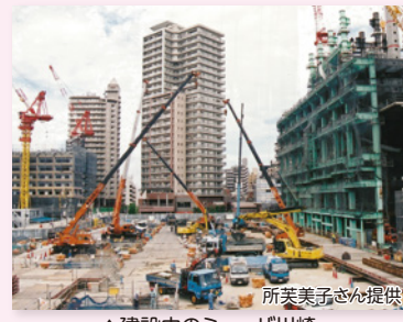
▲建設中のミューザ川崎
