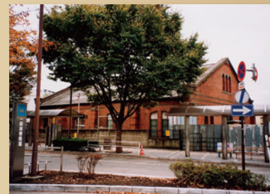
▲旧国鉄川崎変電所(川崎赤煉瓦倉庫)
