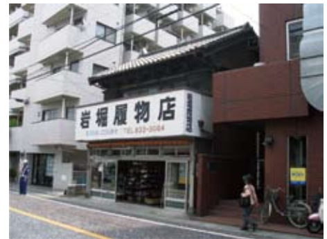
岩堀履物店（蔵） 2008（平成20）年取壊し
