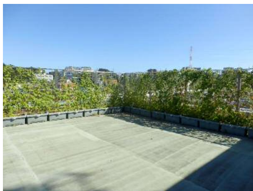
区役所屋上の緑のカーテン
