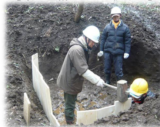
【湧水整備のための杭打ち】
