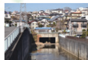
津田山を抜ける平瀬川トンネル
