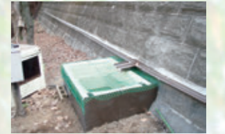
壁面に流れる雨水を貯留槽に集める
