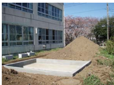
完成したコンクリート池
