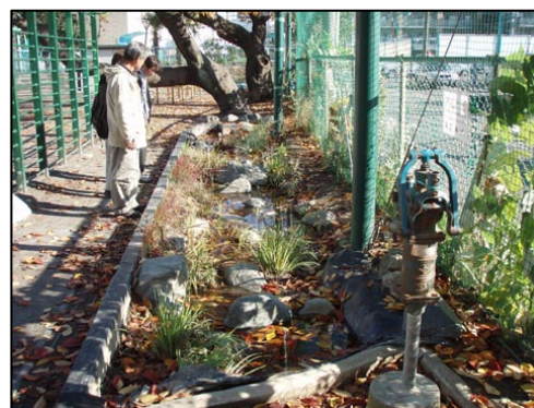
整備前の久地小学校施工場所
