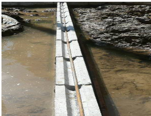
写真4 コンクリートブロックとサイド部分の鉄筋埋め込み
