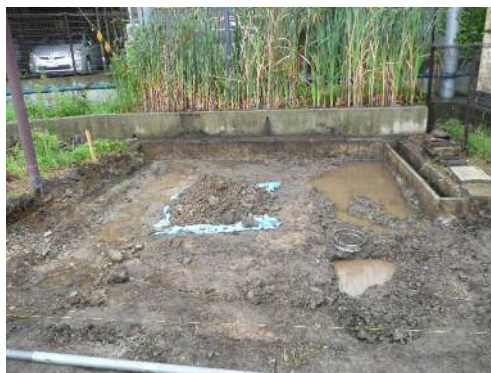
掘削後の整備地（水が全体的に湧き出ている）
