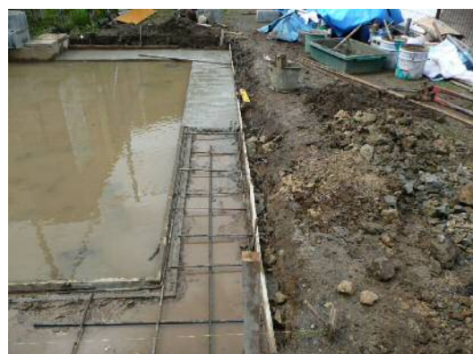
写真4 コンクリートブロックとサイド部分の鉄筋埋め込み
