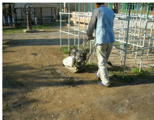
写真6 転圧器による土の締固め
