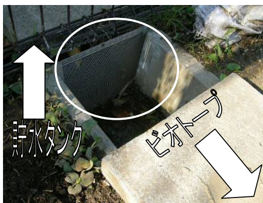
写真2 魚の通行止め金具設置
