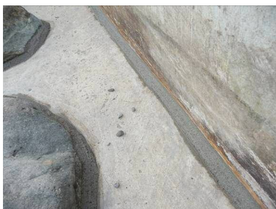
塀の隙間につめたモルタル
