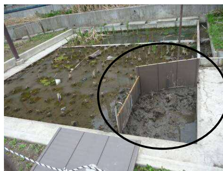
随時、仕切りを設けて水を抜いてから作業
