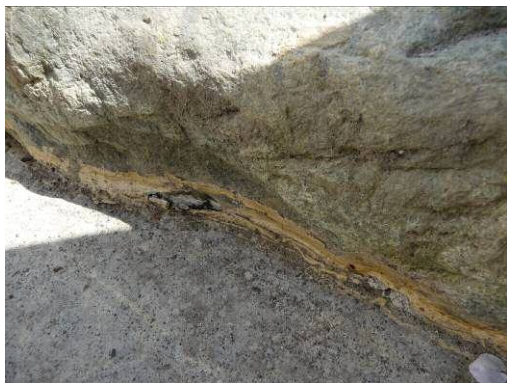
劣化したコーティング剤
