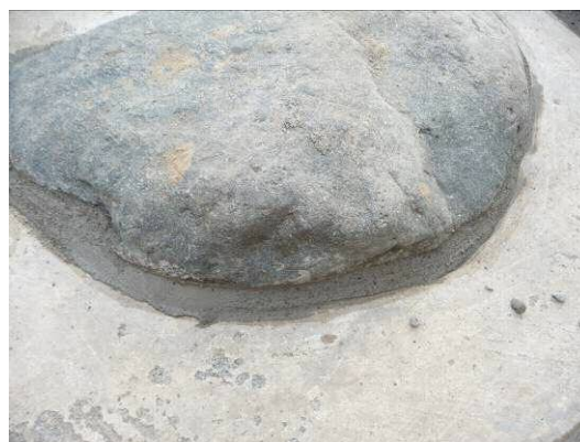
石の隙間につめたモルタル
