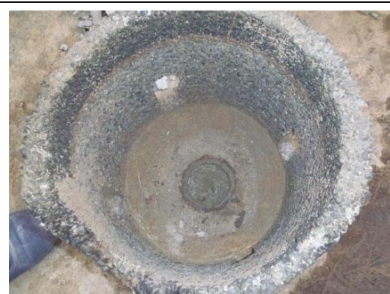
排水溝を塞いだ状態
