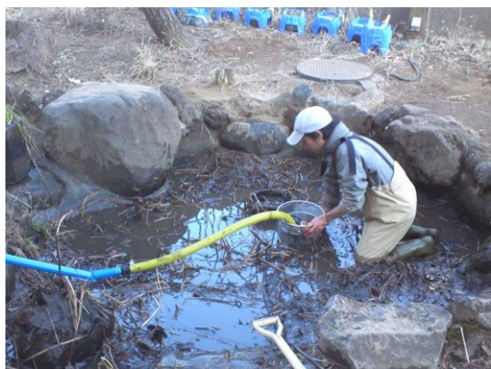
ポンプによる排水
