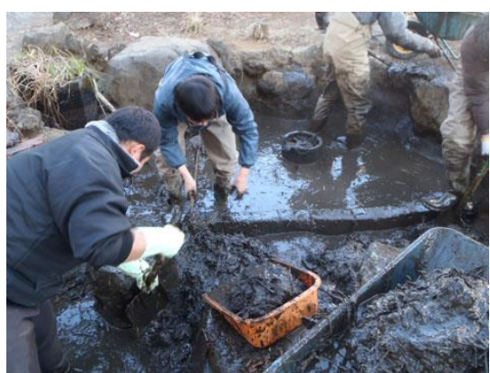
泥の掻き出し
