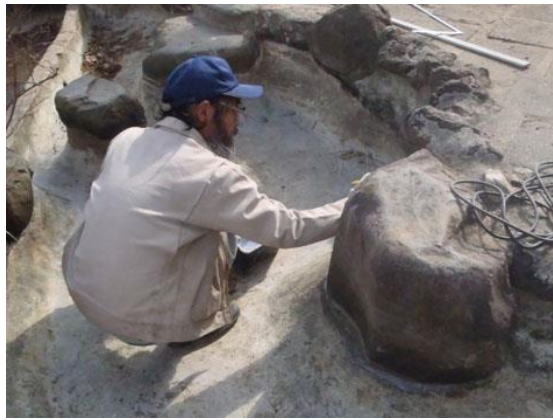
石の隙間埋め作業
