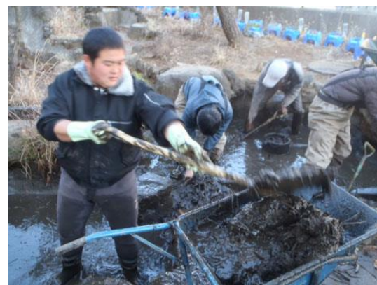
泥の掻き出し
