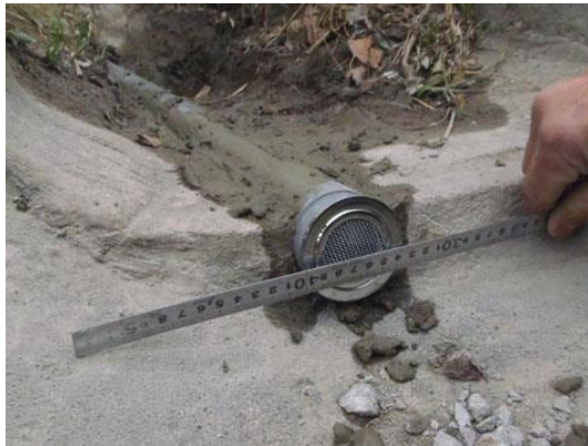
新しい排水口の設置
