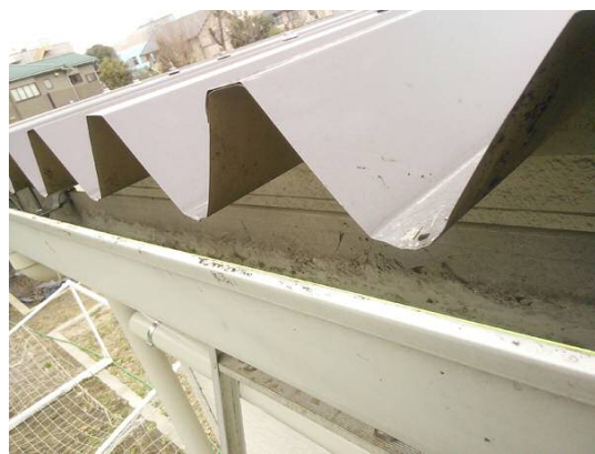
清掃後の雨樋
