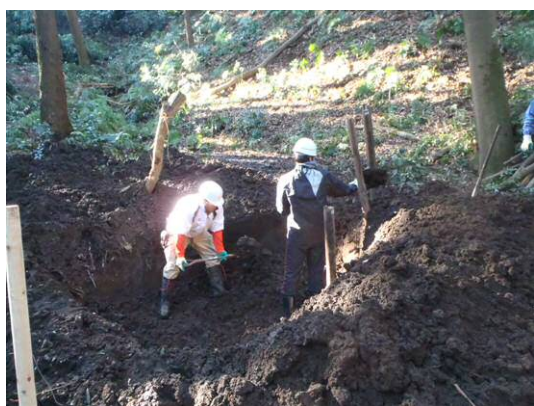
池掘り作業の様子
