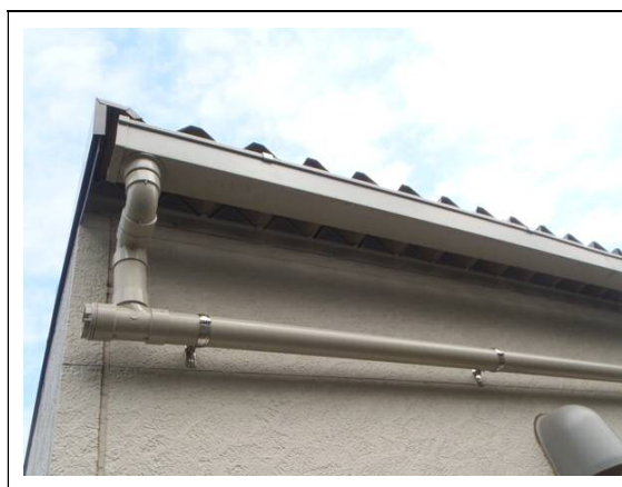
雨樋を背面左側から右側に取り回し
