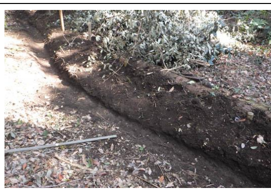
仕上げ後の水路 (2/20)
