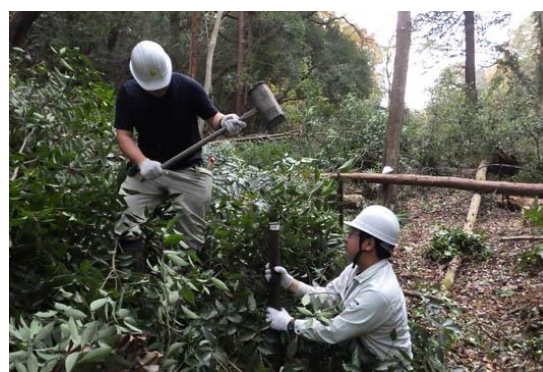
整備作業後の様子 (12/11)
