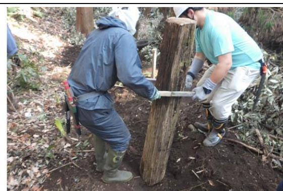
水路の底の突固め (2/20)
