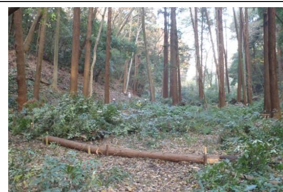
水路開削予定地の整備 (後)
