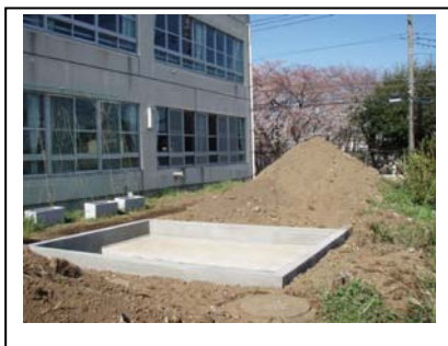
完成したコンクリート池
