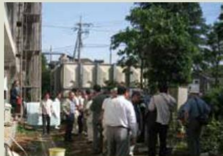
大規模修繕工事の見学会
