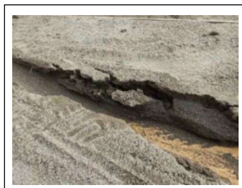
侵食された砂の様子
