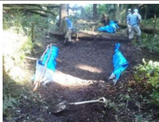
完成した池の様子
