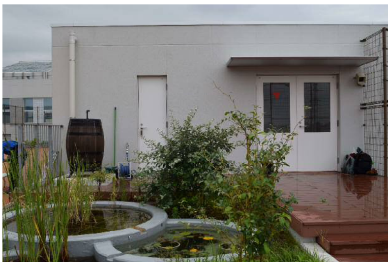
子母口小学校の池のビオトープと雨水の貯留・利用のための雨水樽
