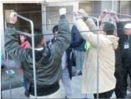
⑦両端と片端がフック型になっているアームを、天井梁の中央上につなげるように差し込む。
