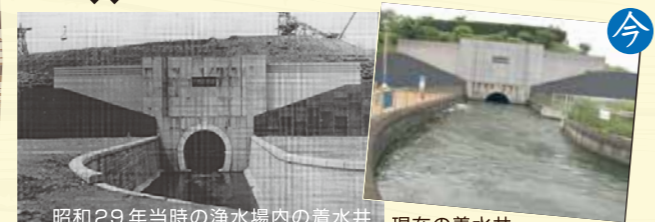
昭和29年当時の浄水場内の着水井 現在の着水井 (平成28年6月20日撮影) 提供: 長沢浄水場
