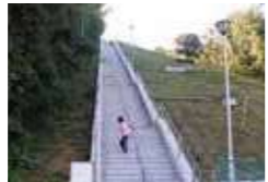
配水池の斜面にある階段 (写真：藤田道夫)
