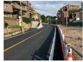
浄水場通り専修大学付近の整備工事
