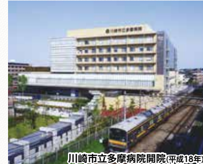
川崎市立多摩病院開院(平成18年)
