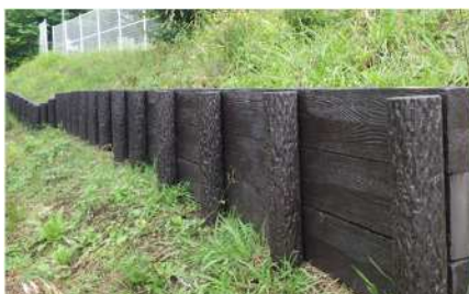
設置後の様子
