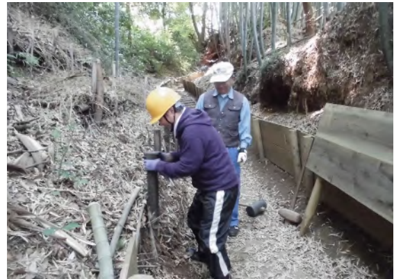
↑ 土留め柵設置の様子
