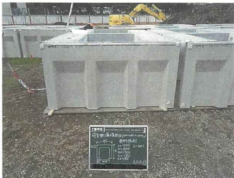
可変側溝横断用設置工
