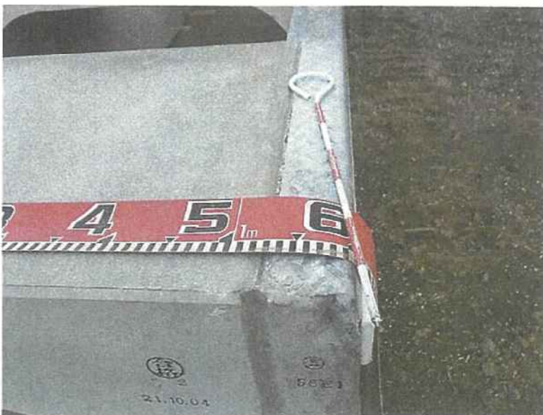
可変側溝横断用設置工
