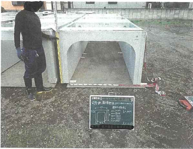
可変側溝横断用設置工
