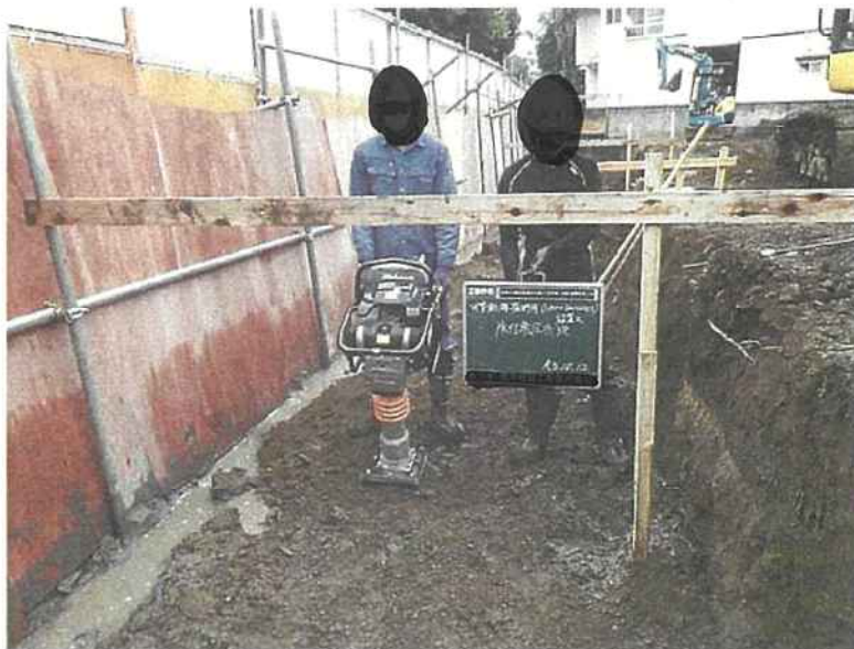
可変側溝横断用設置工 床付転圧状況 令和3年10月12日
