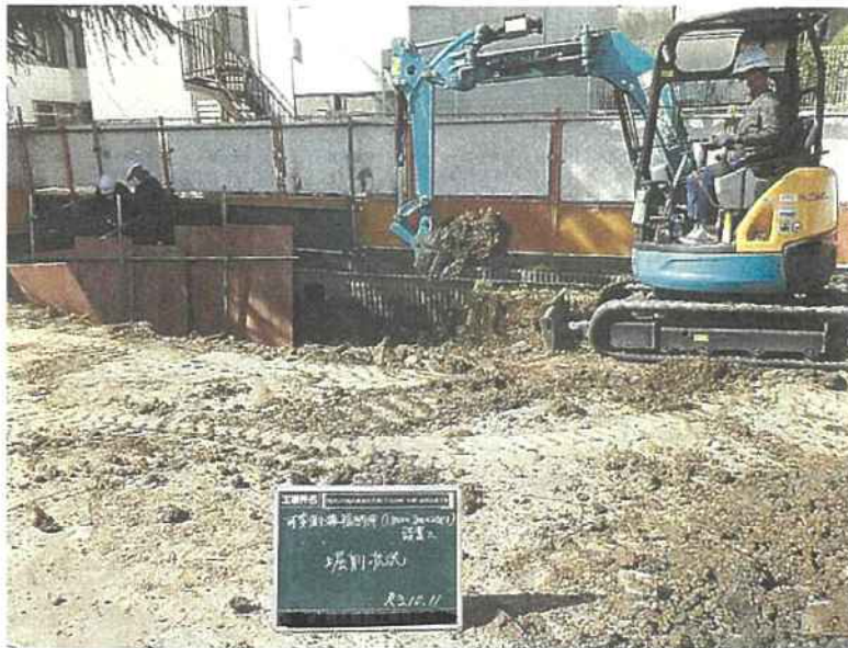
可変側溝横断用設置工 掘削状況 令和3年10月11日
