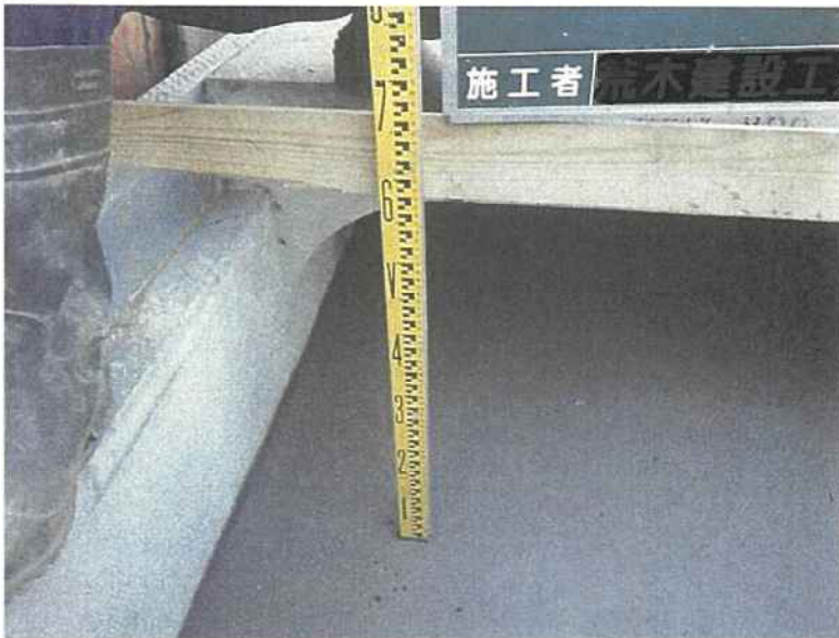
可変側溝横断用設置工 深さ確認 (インバートコンクリート打設後) H=575 令和3年11月6日
