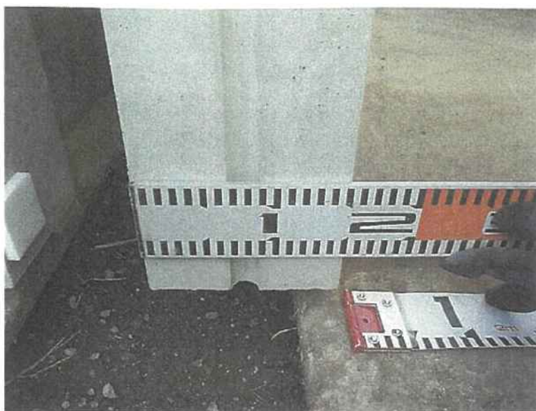
可変側溝横断用設置工
