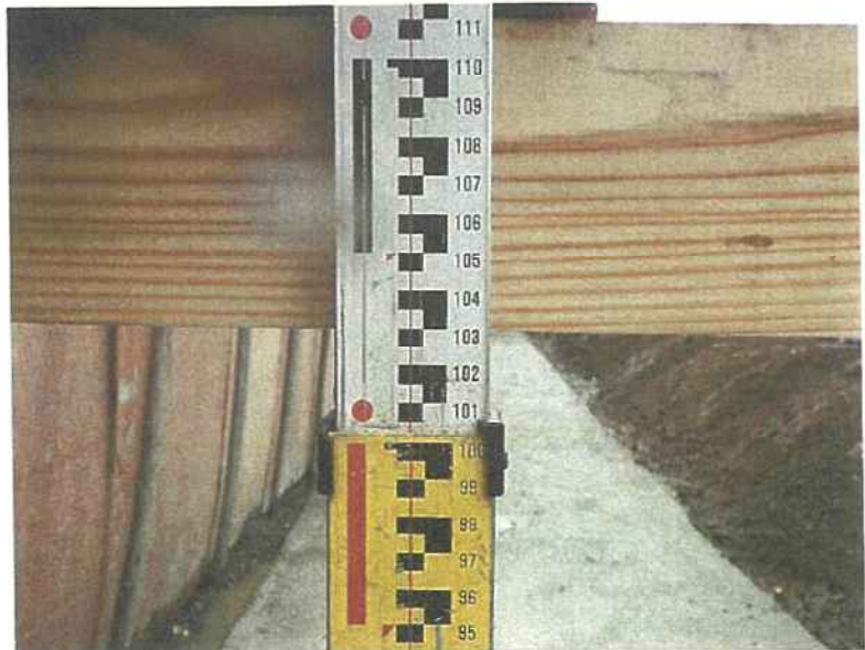
可変側溝横断用設置工 基礎コンクリート出来形FH±0
