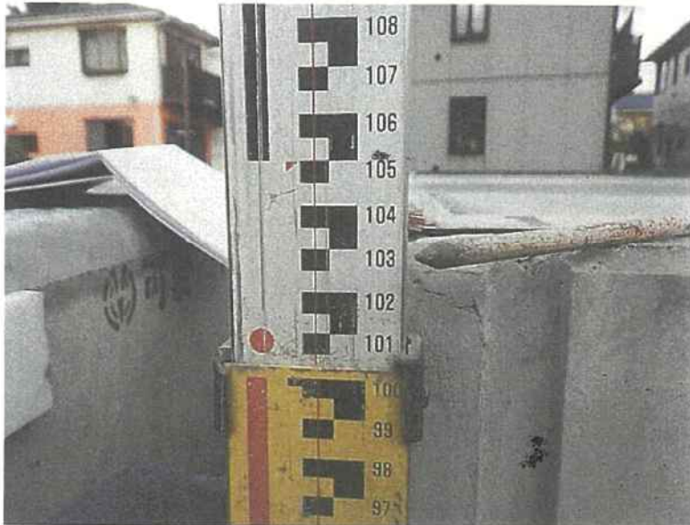
可変側溝横断用設置工
